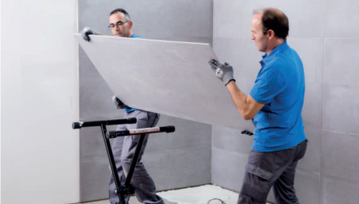
HANDLE THE TILES CORRECTLY Manipula correctamente las piezas · Manipuler correctement les pièces · Behandeln Sie die Fliesen korrekt
