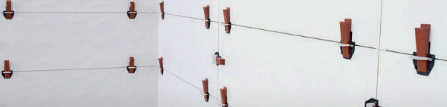
EXAMPLE OF USING THE RLS LEVELLING SYSTEM TO LAY TILES ON WALLS AND FLOORS. · Ejemplo de colocación del Sistema de Nivelación Rls en Revestimiento y Pavimento. Exemple de pose R.S.L.-Système nivelant Raimondi dans les faïences et les carreaux de sol. · Verlegungsbeispiel des RLS Nivelliersystems bei Wandfliesen und bei Bodenfliesen.
