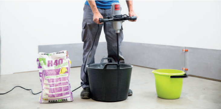
PREPARE THE ADHESIVE CEMENT Prepara el cemento de agarre · Préparer le ciment à prise rapide · Bereiten Sie den Klebemörtel vor
