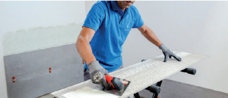
SPREAD THE ADHESIVE CEMENT WITH A TOOTHED TROWEL Extiende el cemento de agarre con una llana dentada · Étendre le ciment à prise rapide à l'aide d'une spatule dentée · Verstreichen Sie den Klebemörtel mit einem Zahnpachtel
