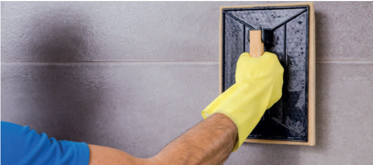
REMOVE ANY LEFTOVER GROUT AND OTHER DIRT Elimina los residuos de junta y demás suciedad · Éliminer les résidus du joints et autres saletés · Entfernen Sie Fugenmaterialreste und andere Verunreinigungen
