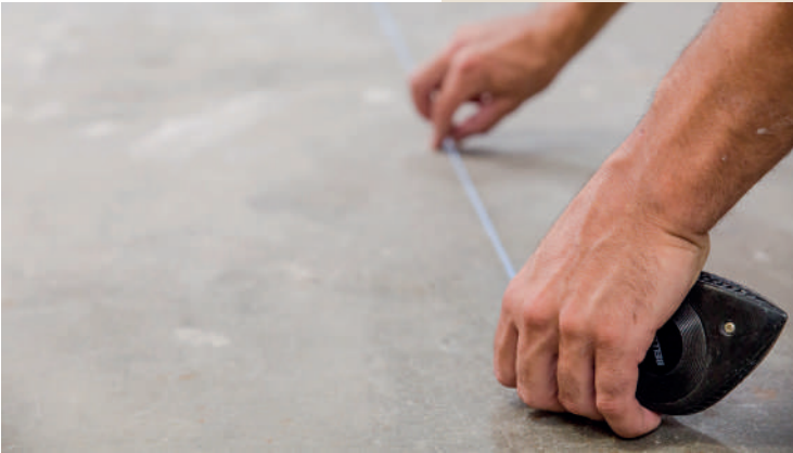
SET THE GUIDELINE Plantea la línea maestra · Établir la ligne principale · Spannen Sie die Richtschnur
