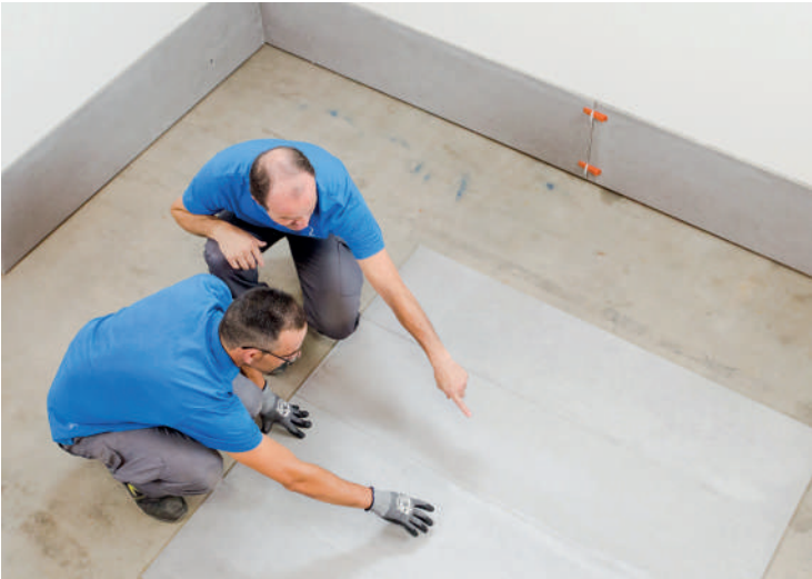
CHOOSE THE LAYOUT OF THE TILES Selecciona la disposición de las piezas · Sélectionner la disposition des pièces · Wählen Sie die Anordnung der Fliesen
