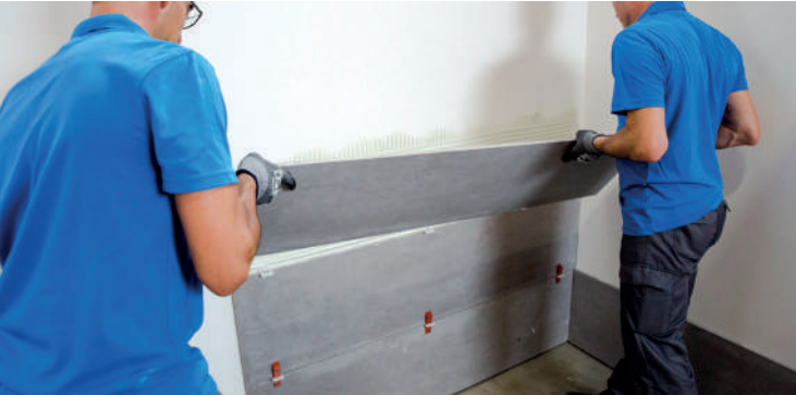
AFFIX THE TILE TO THE PRE-PREPARED SURFACE Coloca la pieza sobre la superficie preparada · Placer le carreau sur la surface préparée · Verlegen Sie die Fliese auf der vorbereiteten Oberfläche
