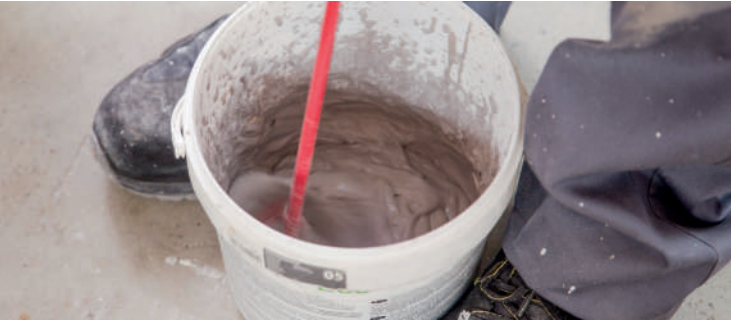
PREPARE THE GROUT Prepara el material de rejuntado · Préparer le matériel de joint · Rühren sie das fugenmaterial an
